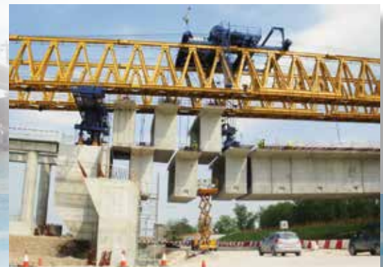
All Photos Courtesy of FCC Construcción S.A.
